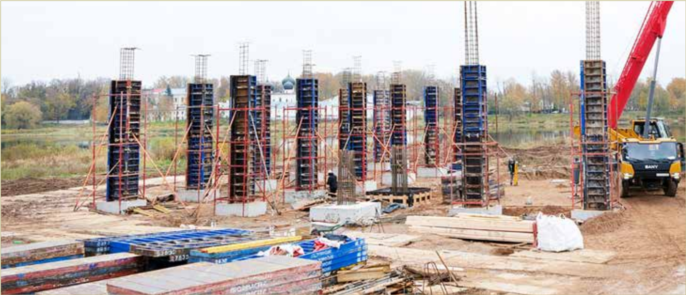
Будущая приводная станция канатной дороги.
