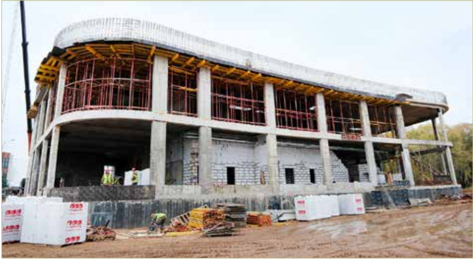
Скоро на корпусе полупроводникового материаловедения приступят к остеклению фасада.
